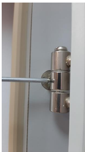
Rys. 1 – regulacja dolegania skrzydła do ościeżnicy za pomocą klucza imbusowego oraz przekładni ślimakowej
